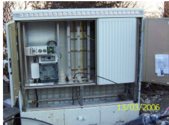
Abbildung 6 Hauptstrasse Fellbach-Öffingen. Links ist der bereits eingebaute Stromversorgungsteil zu erkennen.
