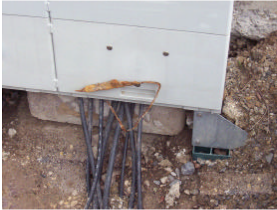
Abbildung 9 Hornbergweg Fellbach-Schmidlen. Fundament und Kabel des überbauten KVz.
