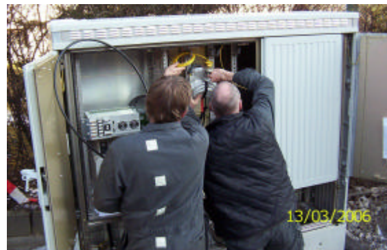
Abbildung 7 Hauptstraße Öffingen. Glasfaser-verteiler einbau.
