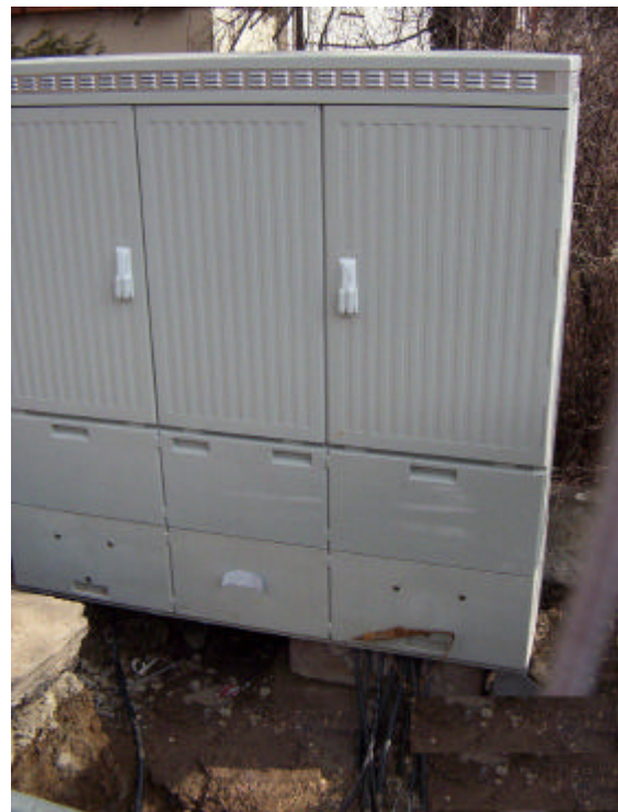
Abbildung 8 Hornbergweg Fellbach-Schmidlen. Fertig überbauter KVz.
