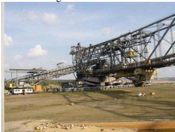
Abbildung 13: Die F60, eine Förderbrücke, die nie in Betrieb war
